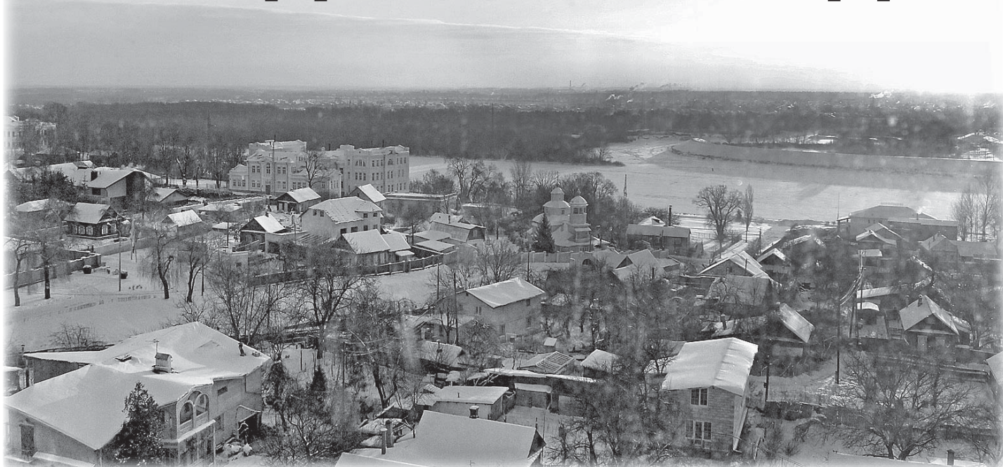
Вид из окон Института леса вдохновляет на путешествие
