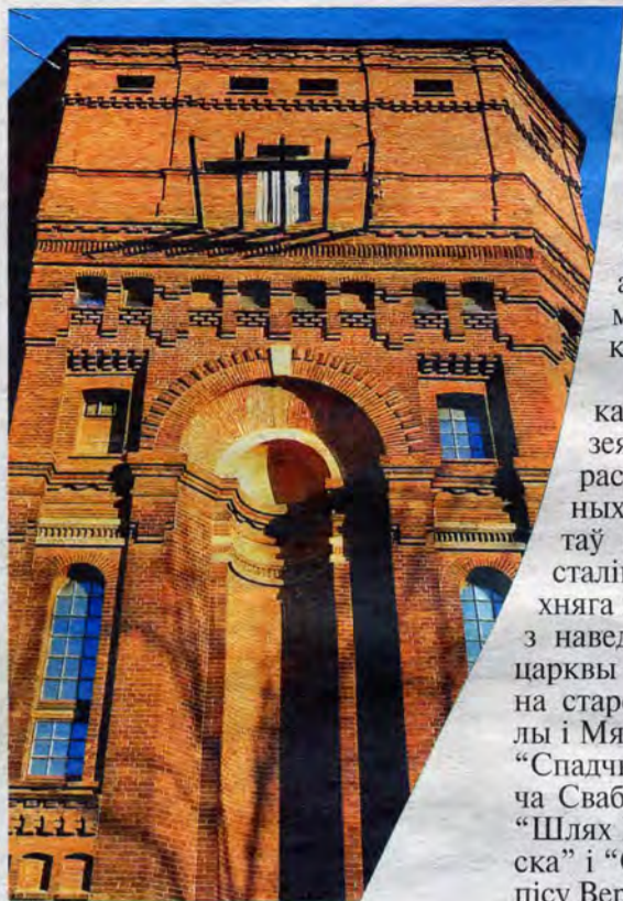
▲ Воданпорная вежа на Аўтадораўскай вуліцы
